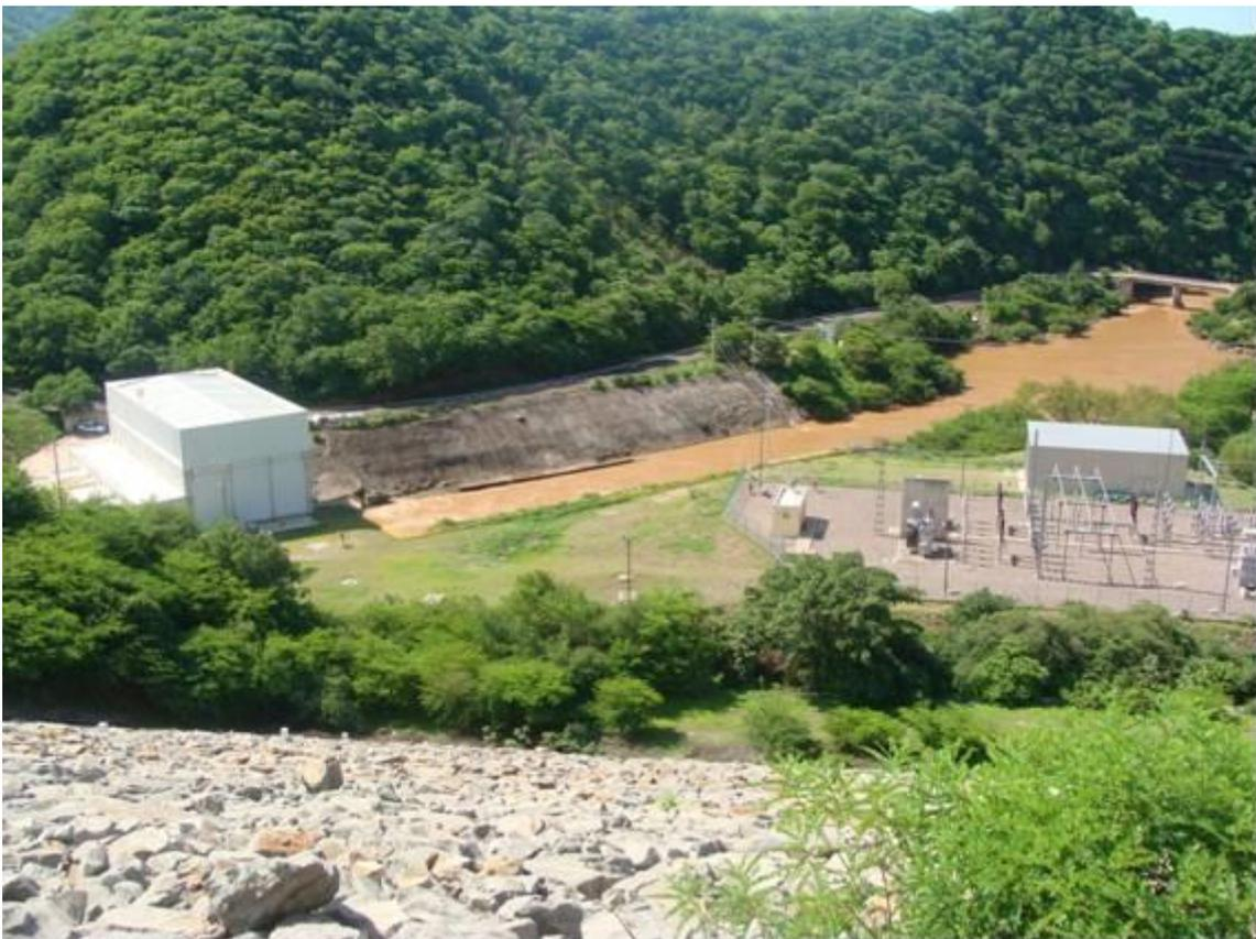
Foto de la Casa de Máquinas y Subestación El Gallo tomada desde la corona de la cortina de la Presa El Gallo. Se aprecia la planta en operación, descargando un volumen de agua turbinada de 75 mil litros por segundo de regreso al río a una velocidad lenta. También se aprecia la reforestación y recuperación de suelos y árboles que durante la construcción de la planta se habían afectado.
